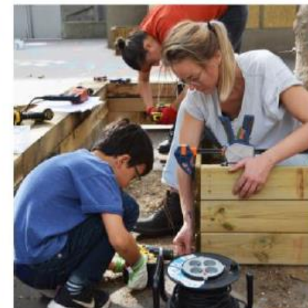
Etape 3 : Mise en place et fixation du bac en bois autour de l'arbre.
